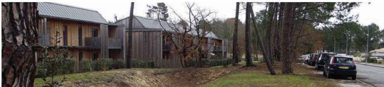
Noue en site « sable des Landes » avec présence de la nappe phréatique à faible profondeur.
